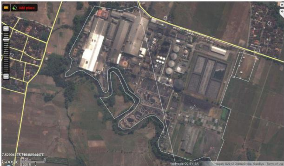
Gambar 2.1 Tampak atas dari perusahaan PT Indo Acidatama Tbk
