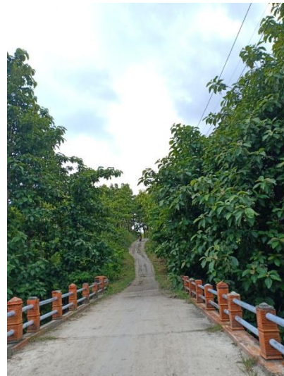
Jembatan penghubung untuk ke daerah lain di Suku Samin
